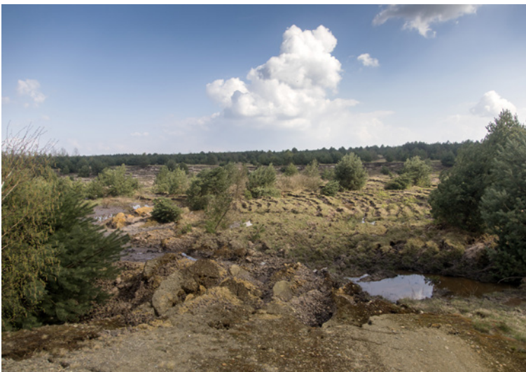
Abb. 24: Innenkippe des früheren Braunkohle-Tagebaus Schlabendorf Süd nach einem Grundbruch. – Inner dump of the former open-pit brown coal mine Schlabendorf Süd after a ground seepage.
